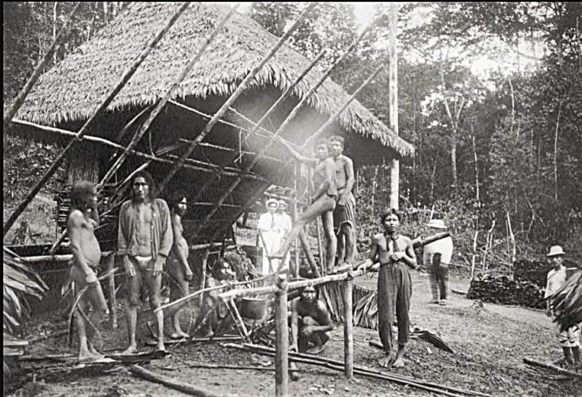
Un alto en la faena de construcción de una vivienda con diseño vegetal para albergar a nuevos peones de uno de los fundos.
