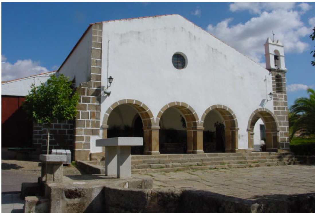
Vista general de la ermita
