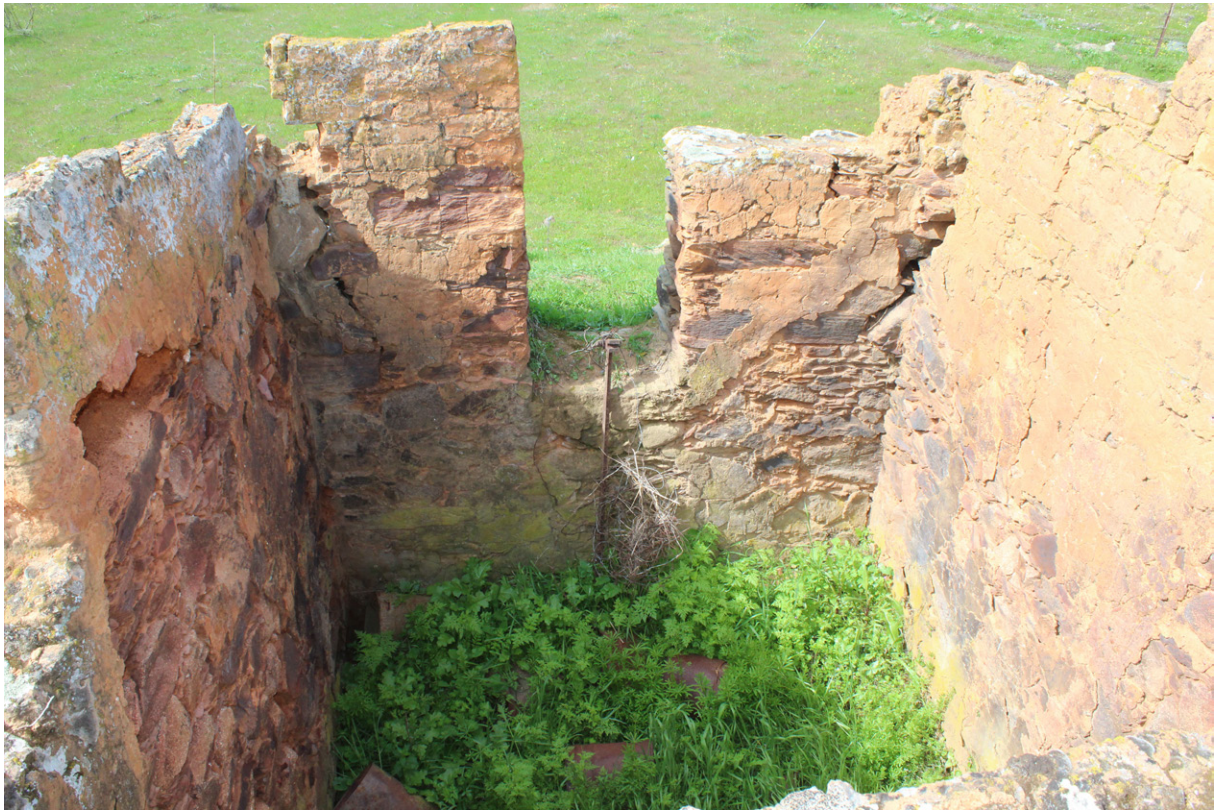
Imágenes 15 y 16: cámara de cocción de las tejas y ladrillos en la parte superior y caseta-almacén
