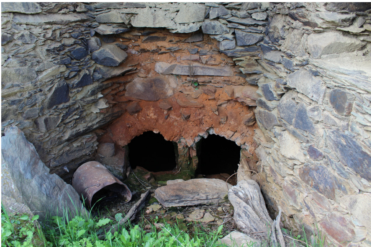
Imágenes 13 y 14: caldera del horno con los orificios para introducir la leña. Se pueden ver las piedras quemadas alrededor
