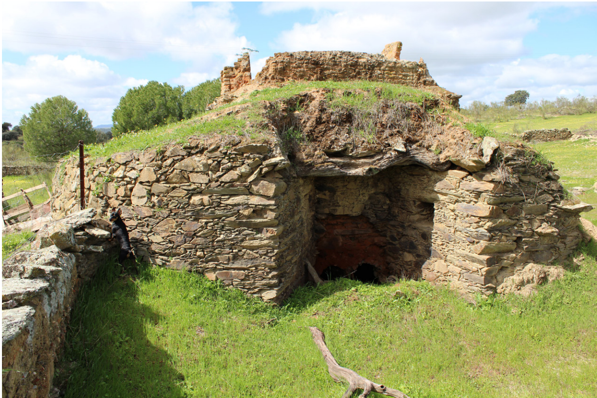
Imágenes 13 y 14: caldera del horno con los orificios para introducir la leña. Se pueden ver las piedras quemadas alrededor
