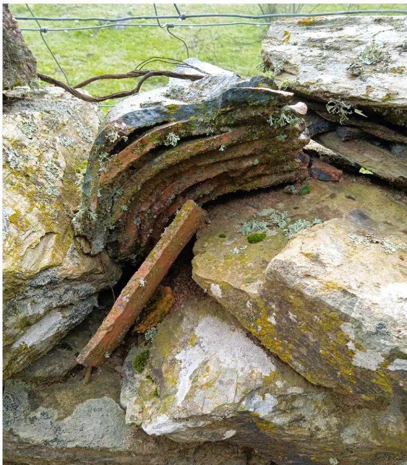
Imágenes 17 y 18: construcción de tapial tradicional a tres «cuerpos» en la caseta. Aún es posible encontrar en el tejado algún montón de tejas de las que allí se hacían, las cuales fueron desechadas por quedarse pegadas durante la cocción
