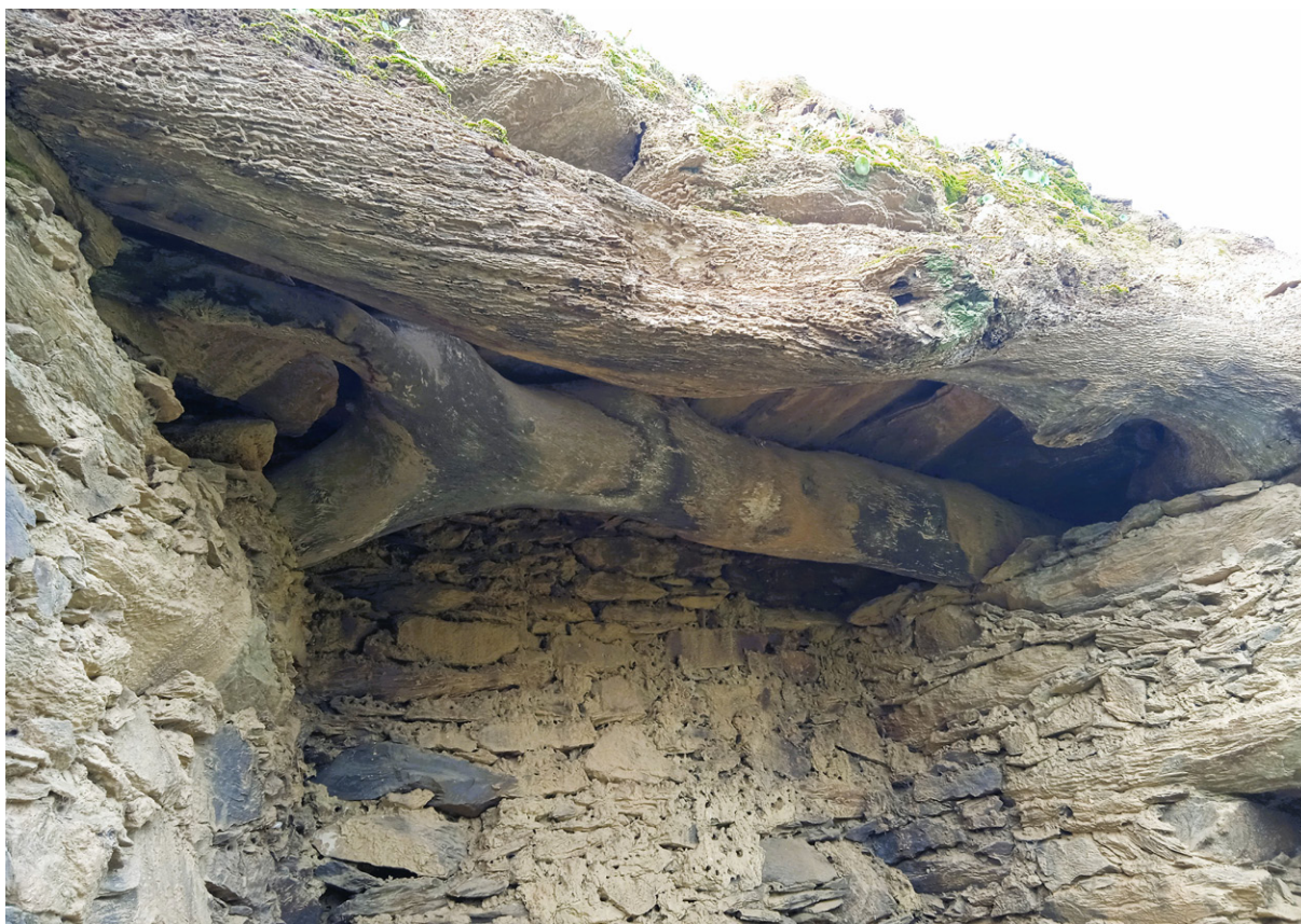
Imagen 9: vigas de tronco de encina sujetando grandes lanchas de pizarra y que cubren la entrada de la caldera. En el hueco entre ambas había una tercera viga, hoy caída en el suelo
