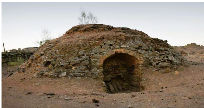
Imágenes 19 y 20: otros tejares de la comarca Montánchez-Tamuja. El de la izquierda presenta un porche hecho en arco de ladrillo. Tiene el orificio de entrada de la leña tapado con lanchas de piedra
