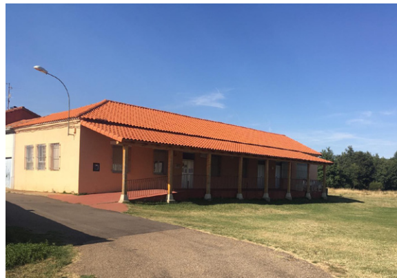
Escuela modificada y reformada de Palacios de Jamuz
