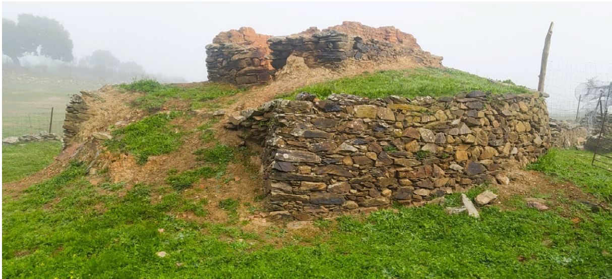
Imagen 7: lado de acceso a la cámara de cocción (opuesto al de la caldera)
