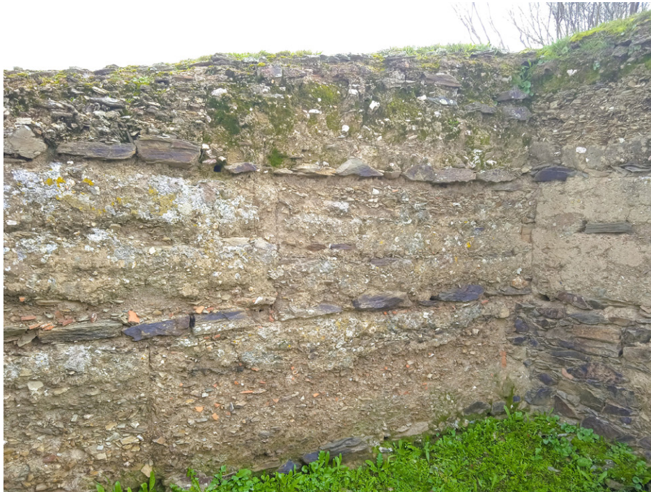
Imágenes 17 y 18: construcción de tapial tradicional a tres «cuerpos» en la caseta. Aún es posible encontrar en el tejado algún montón de tejas de las que allí se hacían, las cuales fueron desechadas por quedarse pegadas durante la cocción
