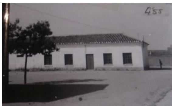
Escuelas y viviendas de maestros en Jiménez construidas en 1955
