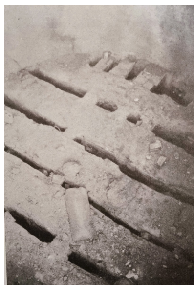
Imágenes 1 y 2: ejemplos de «parrillas» de la cámara de cocción. Fuente: GONZÁLEZ, 1989: 64 y 69
