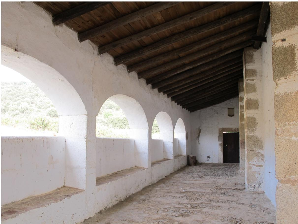
Pórtico, con arcos carpaneles y cubierta de madera
