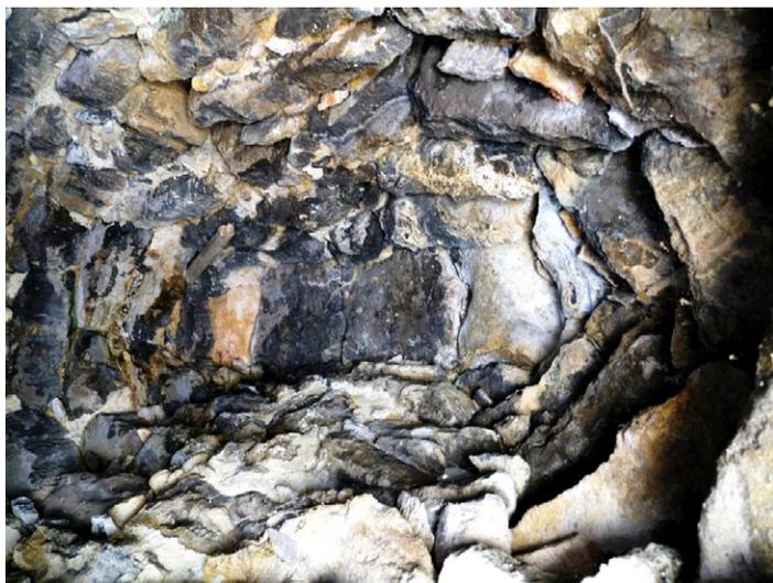
Fig. 20. Villamediana. Cubierta abovedada por aproximación de hiladas y cierre con varias losas de la caseta de la figura anterior
