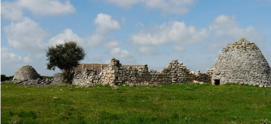
Fig. 1. Corrales de la Tiñosa, que significa la «leñosa», en Vertavillo (Palencia), donde se aprecian dos grandes chozos, los muros arruinados y las parideras y tenadas con cubierta de teja, que antaño fue de leña
