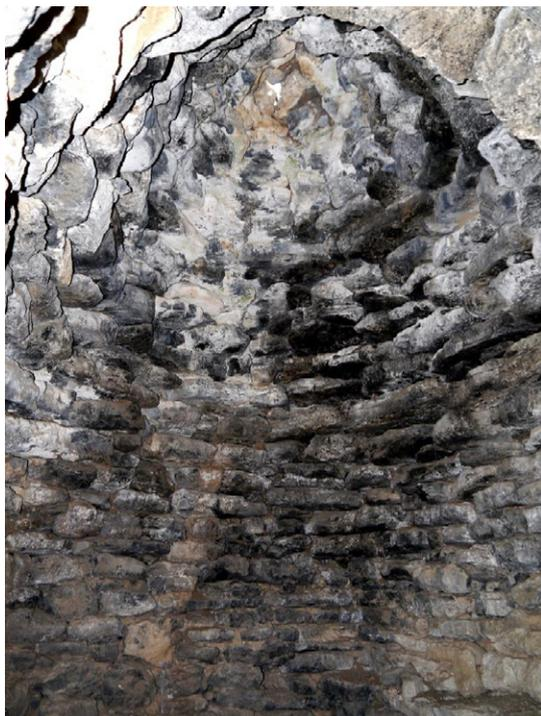
Fig. 16. Interior de la cúpula, con grandes pechinas que permiten pasar de la planta rectangular al cierre mediante una cupulilla casi semiesférica
