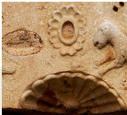
Fig. 3. Venera y espejo ovalado en la ventana de la planta baja. A un lado del espejo hay una gran coquera de la piedra tapada con mortero
