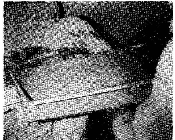
IV.—Colocación de la teja cortada sobre el galápago
