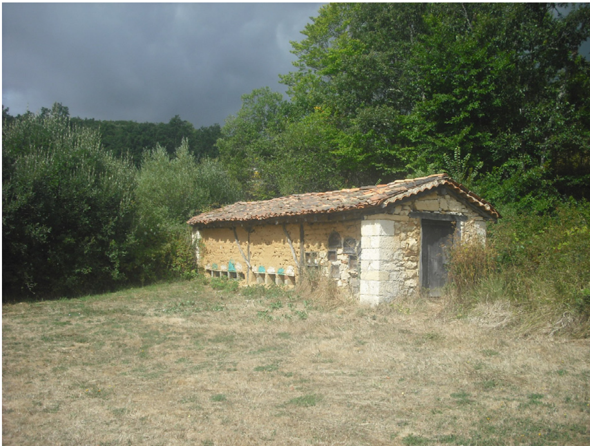
Fotografía 3: Colmenar de Dehesa de Montejo. Construcción de gran belleza y calidad constructiva en la que destacan sus muros laterales, en parte contruidos en perfecta sillería
